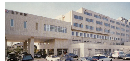
改築工事後の山下病院
